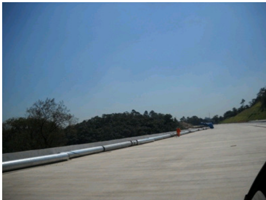
FIGURA 1 – Instalação de Tubos Acoplados a Caixa de Retenção
