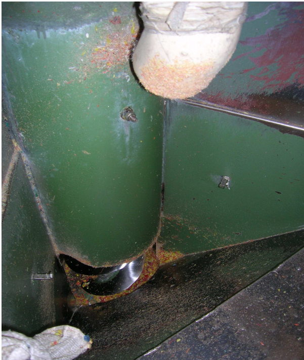
Figura 10: Detalhe do funcionamento do misturador e retorno do material Fonte: Arquivo do Autor, (2009).
