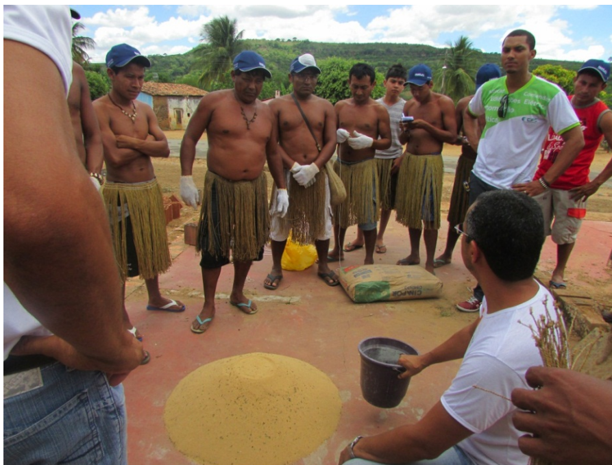
Figura 4 – Aula de misturação e preparação do cimento no curso de pedreiro
