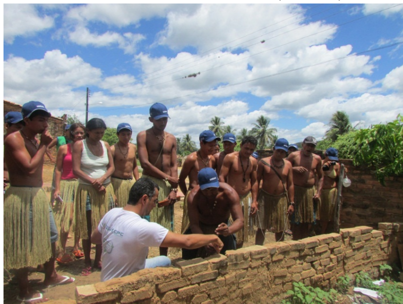
Figura 3 – Momento do curso de Construção de Tanques e Pequenas Barragens
