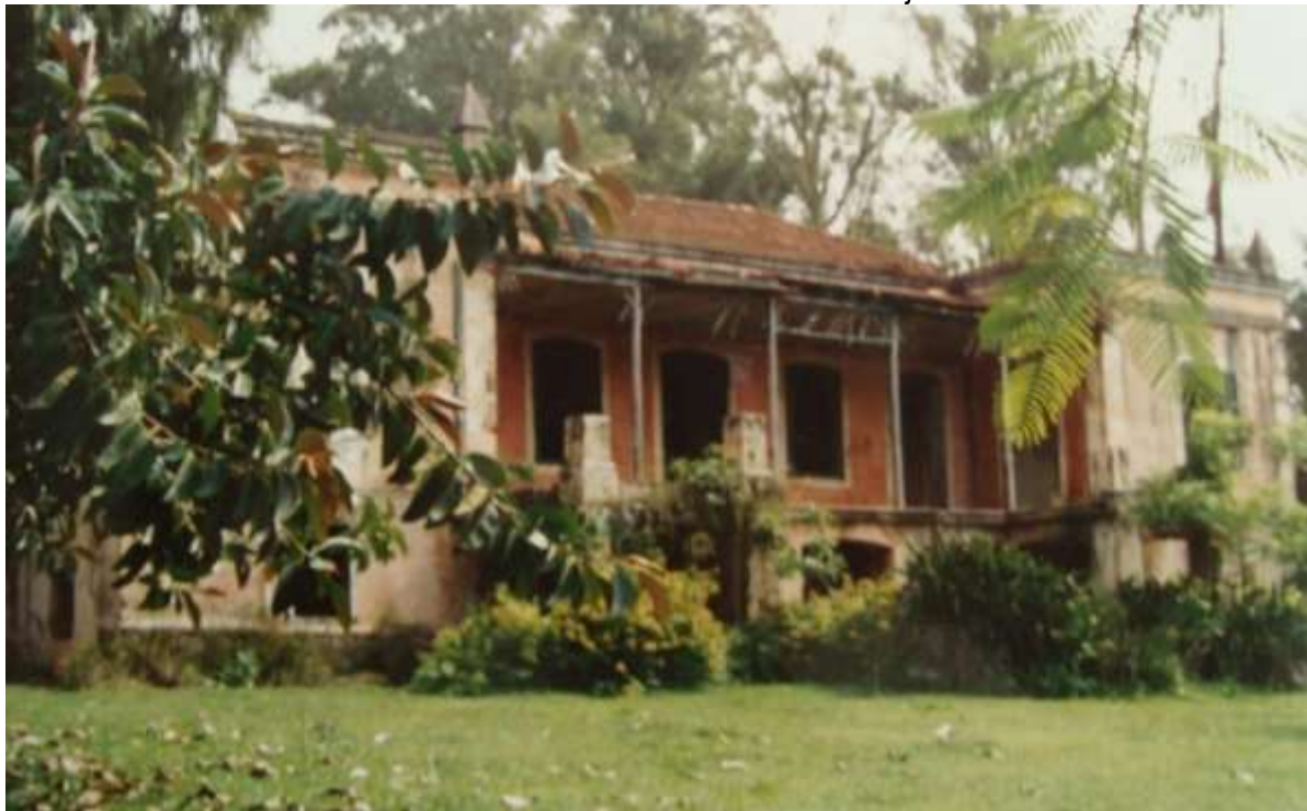
Figura 2: Fachada da sede da Fazenda Jambeiro. 20 de agosto de 1994. Papel. Processo de Tombamento nº007/89 – Fazenda Jambeiro de 2 de junho de 1989.
