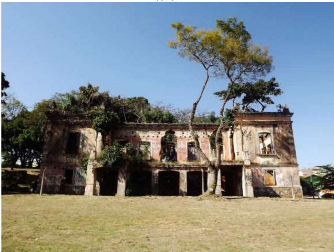
Figura 4: Fachada da sede da Fazenda Jambeiro. Fotografia feita em visita técnica no dia 23 de agosto de 2014
