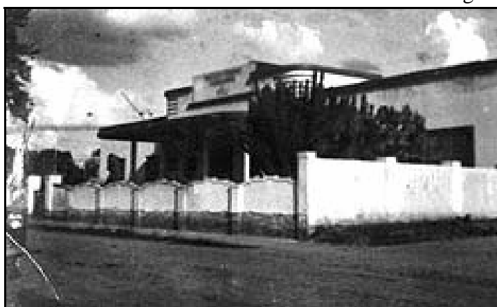
Figura 2: Fachada do Núcleo Ferroviário de Pindamonhangaba
