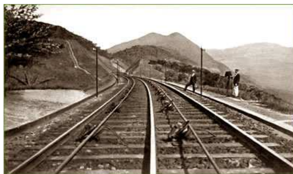
Figura 3: Cabos do sistema funicular que tracionavam as composições no trecho da Serra do Mar por volta de 1867.
