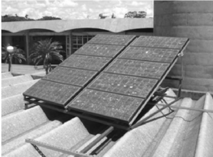
O posicionamento do conjunto fotovoltaico foi realizado por meio de uma haste vertical projetada sobre um plano horizontal, pela localização do norte geográfico utilizando o valor do meio-dia real (12 horas, 43 minutos, 44 segundos). O ângulo de inclinação do conjunto fotovoltaico em relação ao plano horizontal foi mantido constante e idêntico à latitude do local (GNOATTO, 2005).
